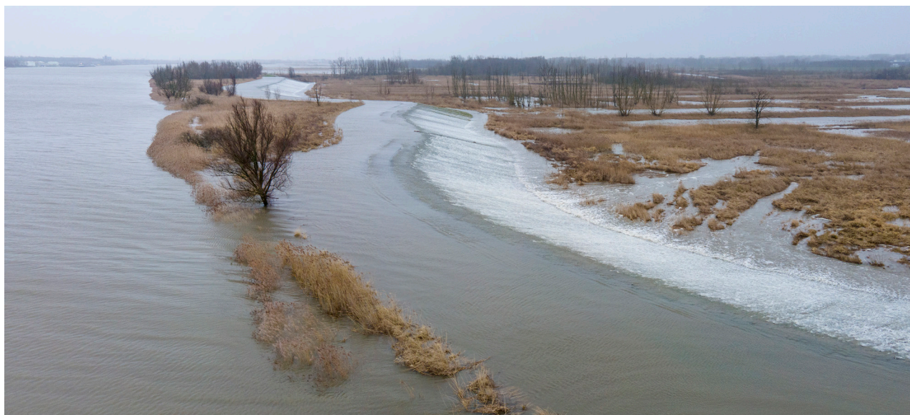
Figuur 8. GOG Kruibeke-Bazel-Rupelmonde langs de Zeeschelde in volle werking... water loopt gecontroleerd over de dijk in het overstromingsgebied en de hoogwatergolf wordt afgetopt. Bron: DVW afdeling Regio Centraal.
